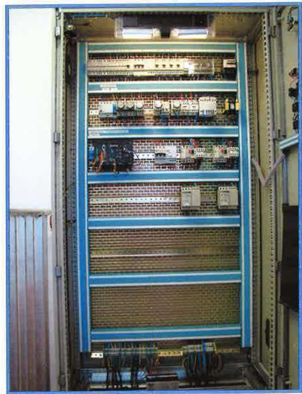
Un affichage de contrôle équipé de boutons poussoirs, d'interrupteurs de sélection et de voyants à leds assurent une visualisation complète et immédiate de tous les états du surpresseur. De plus, un compteur horaire est prévu pour chaque pompe ainsi qu'un ampèremètre et un voltmètre général.
